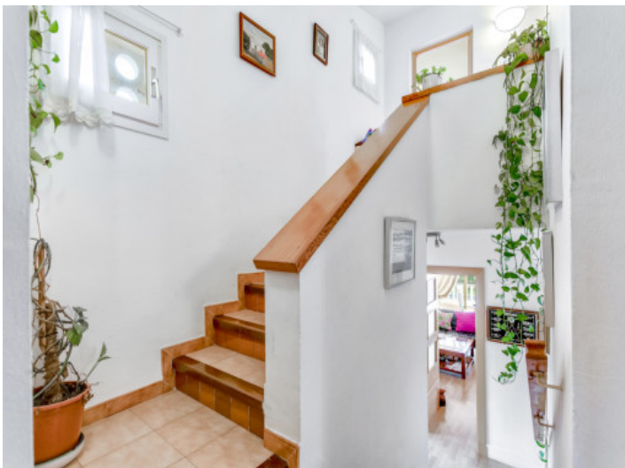
Treppe zum Obergeschoß
