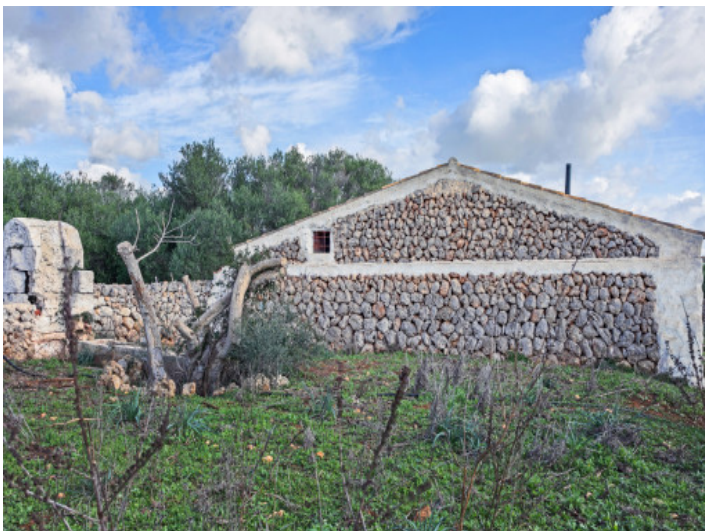
Ansicht der Fassade
